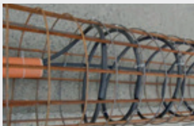
▲ Obr. 7, 8 Energetické piloty slouží pro odebrání energie pro potřeby vytápění a naopak pro ukládání odpadního tepla při potřebách chlazení
