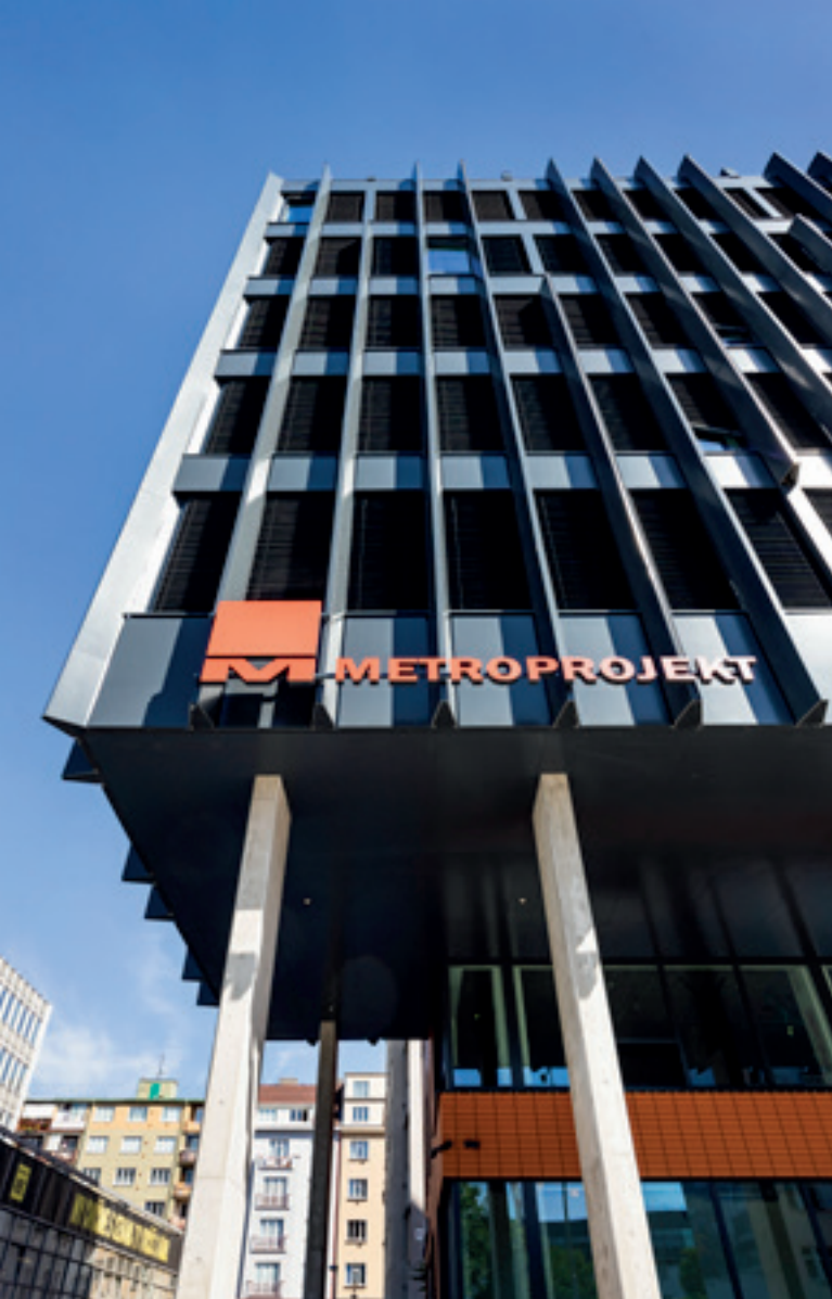
▲ Obr. 13 Fasáda ustoupené části 1. a 2.NP je prosklená, bez lamel
