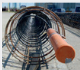
▲ Obr. 7, 8 Energetické piloty slouží pro odebrání energie pro potřeby vytápění a naopak pro ukládání odpadního tepla při potřebách chlazení
