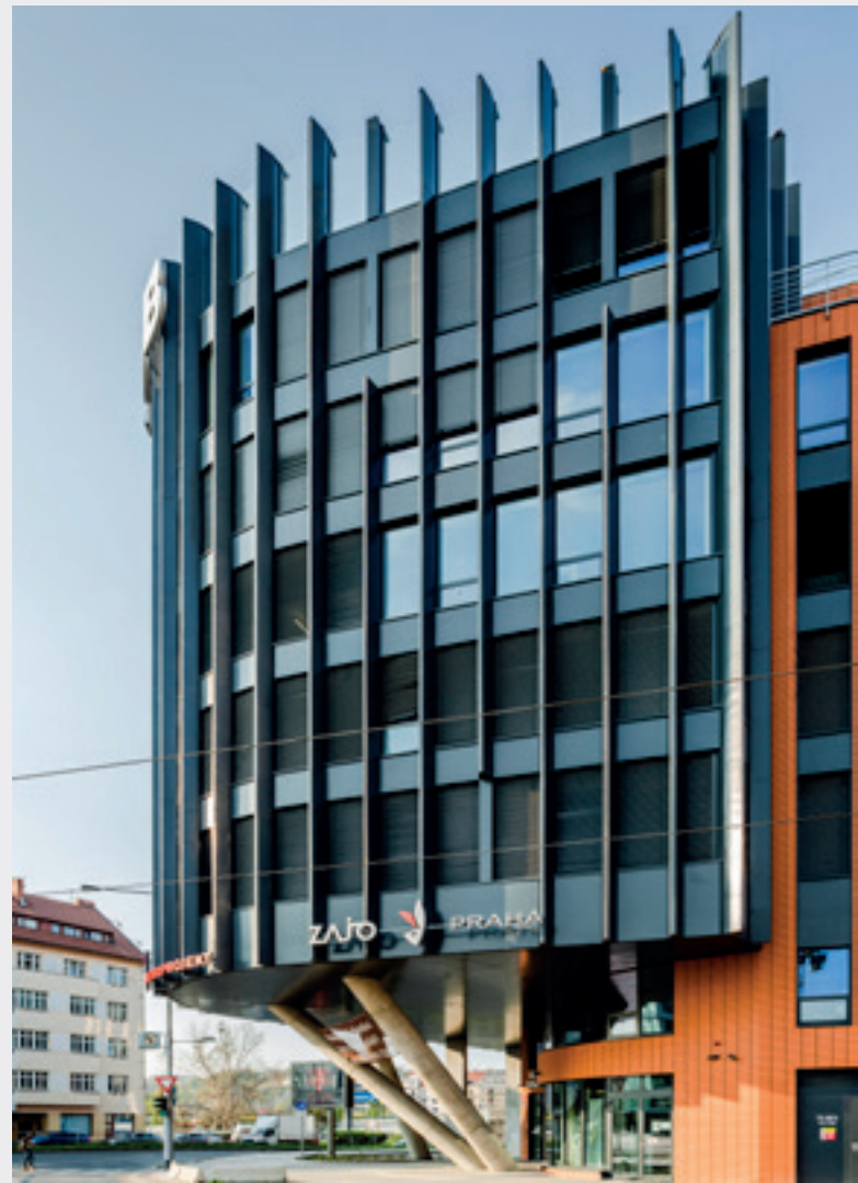
▼ Obr. 2 Dominantním prvkem budovy je trojice šikmých sloupů podpírajících nároží v úrovni ustoupených podlaží (foto: Tomáš Malý)
