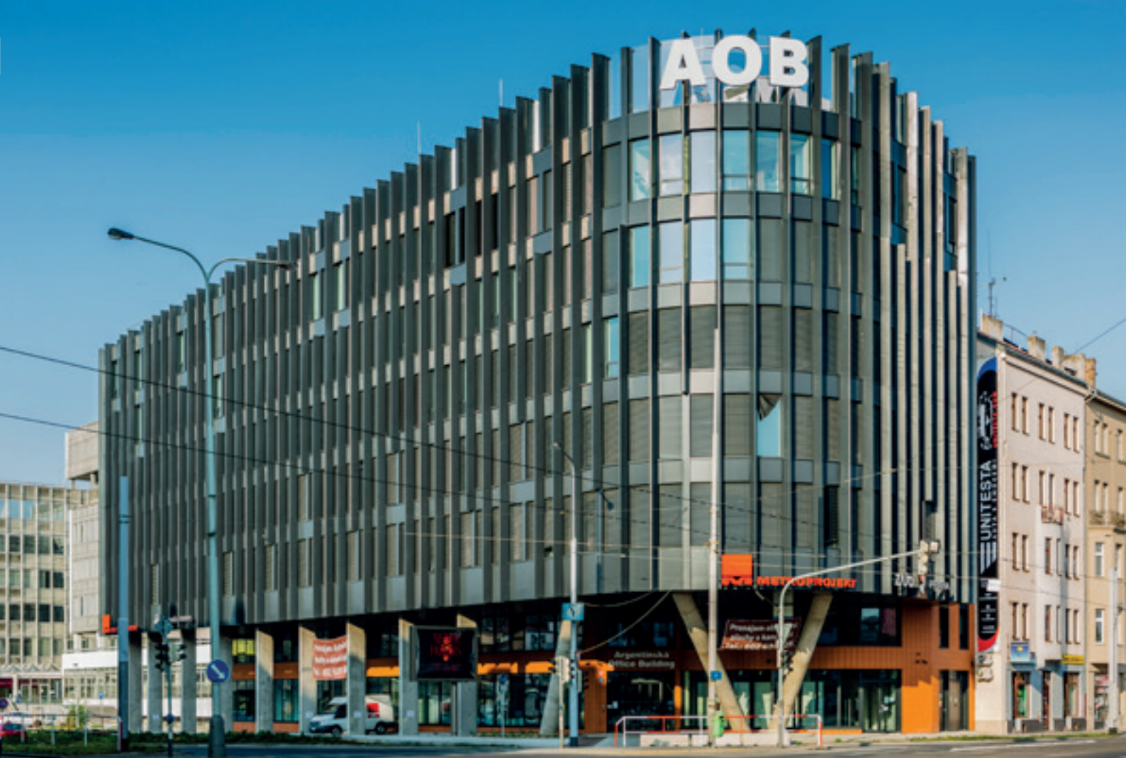
▲ Obr. 3 Administrativní budova Argentinská Office Building v Praze-Holešovicích, pohled z křižovatky ulic Argentinská a Plynární (foto: Tomáš Malý)
